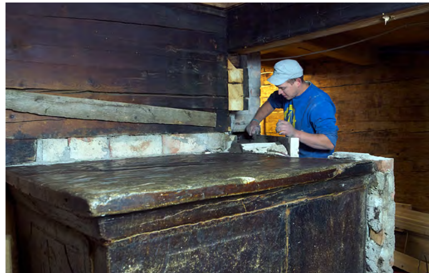
Die Bohlenwand ist entfernt. Die Kaminverbindung zum Hauptkamin wird neu aufgemauert.
