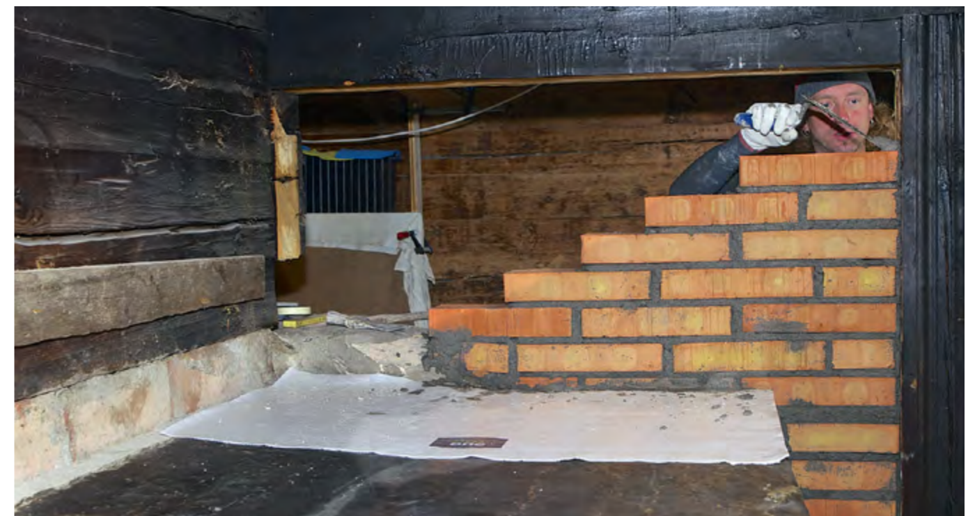
Die Bohlenwand zwischen dem Ofen und der Einfuerungsstelle wurde entfernt, das neue Backsteinmauerwerk wird aufgemauert.
