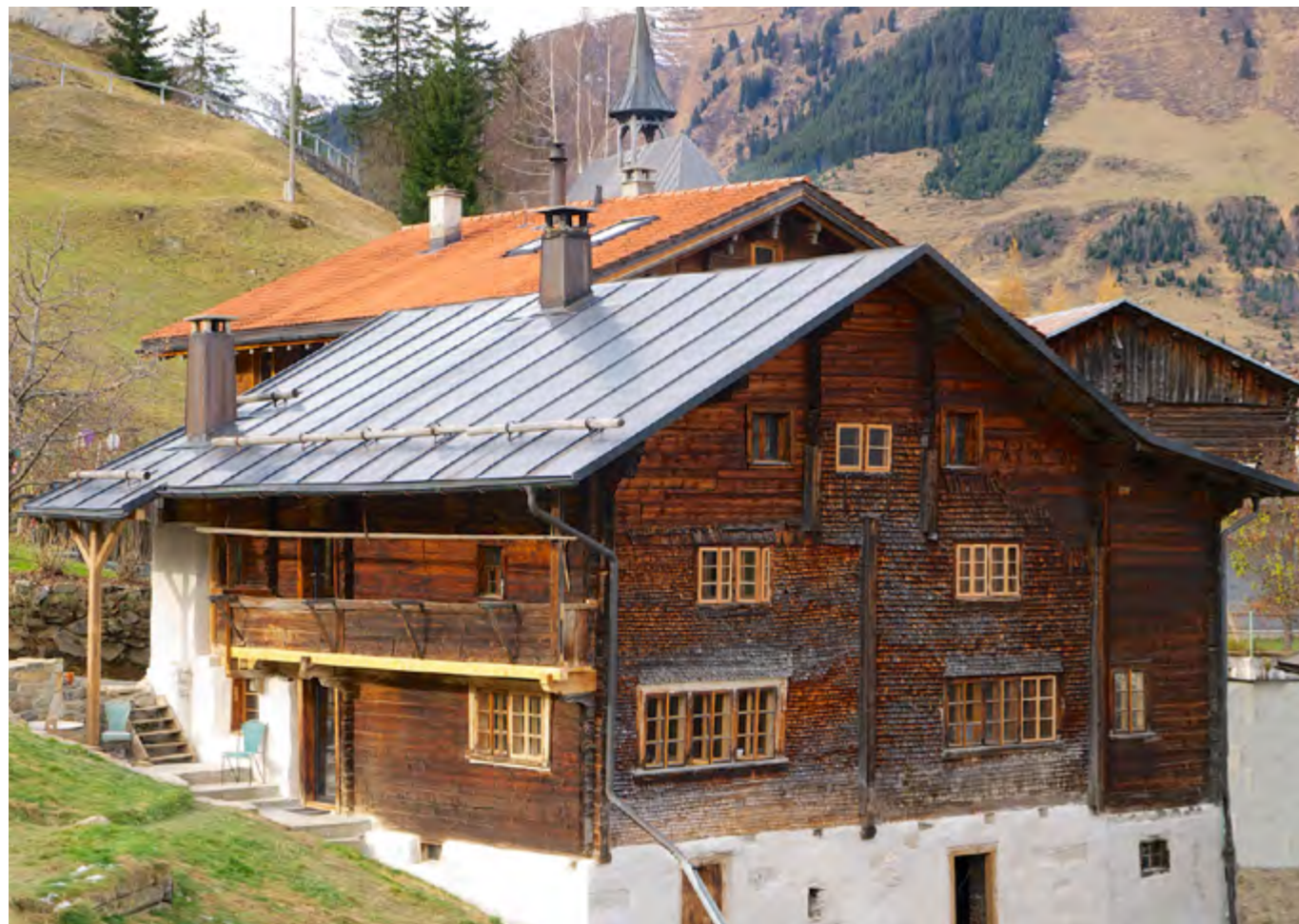
Das Walserhaus, Baujahr 1801 – renoviert mit einem ursprünglichen Kalkverputz
